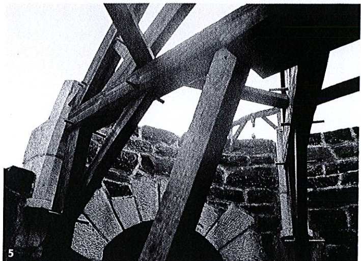
4. LE CALCUL DE RÉPARTITION DES CHARGES a exigé une très grande rigueur lors de la taille et de l'assemblage des pierres.
