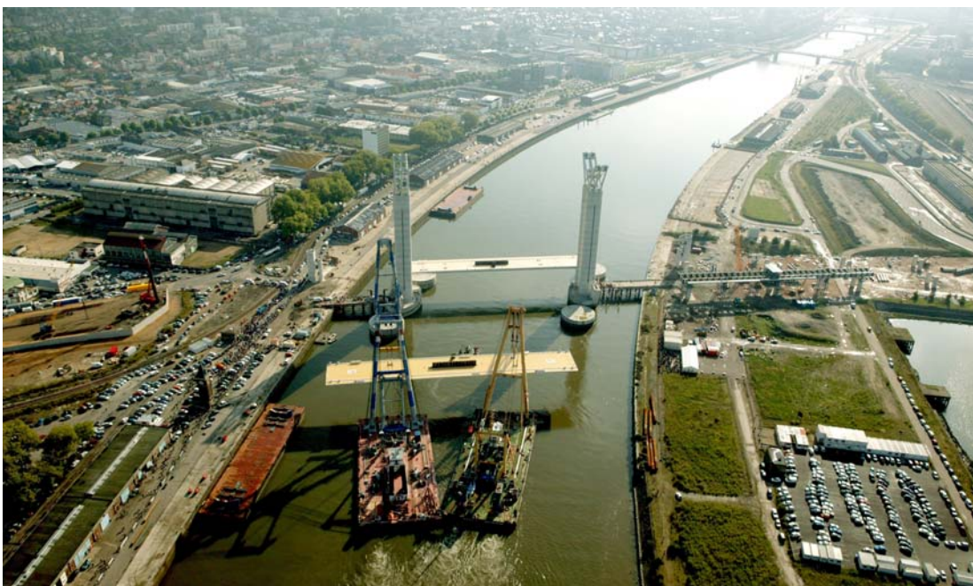
Photo 18 : Pose de la 2 ème travée
