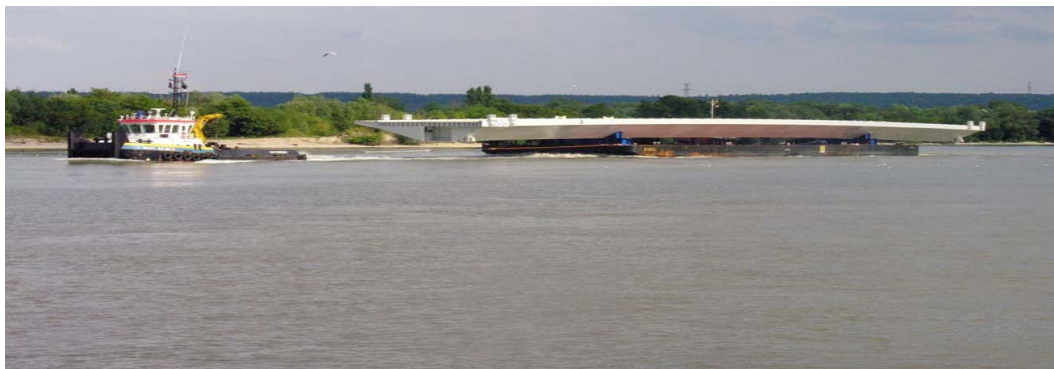
Photo 14 : Remontée de la Seine d'un tablier
