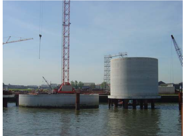
Photo 3 : Socle après descente par vérinage (à gauche) et gabion en attente de descente
