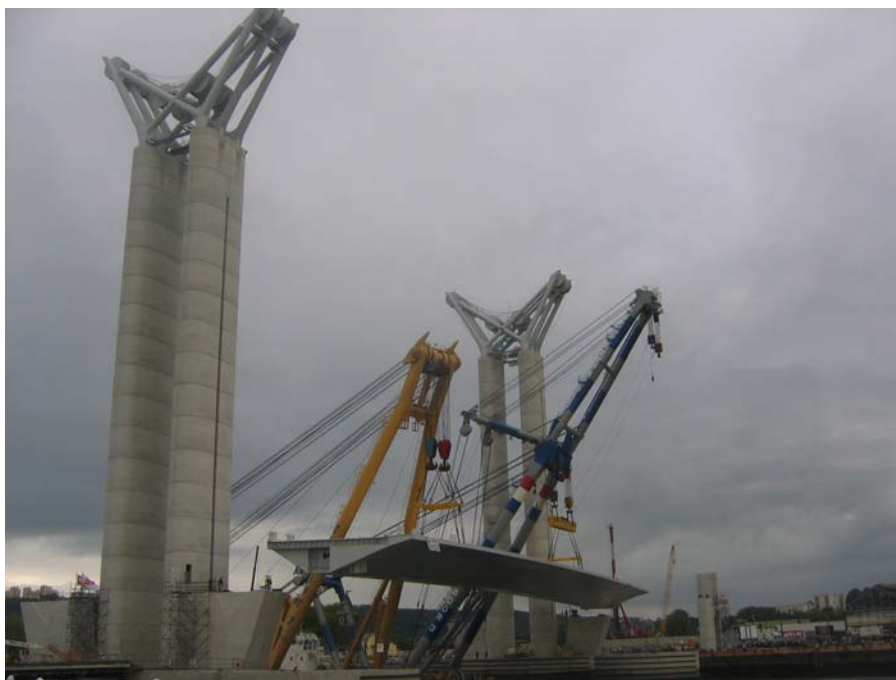
Photo 16 : Pose 1 ère travée
