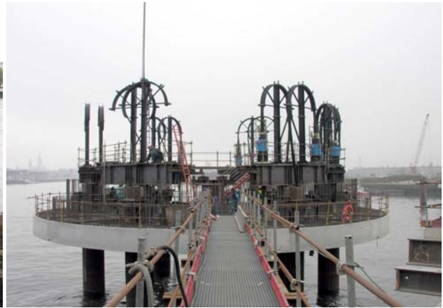
Photo 6 : Installation du système de vérinage pour descente d'un gabion (avant réalisation des voiles latéraux)
