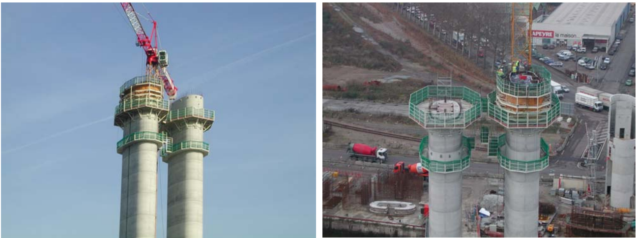
Photos 8 et 9 : Réalisation des pylônes par coffrages grimpants
