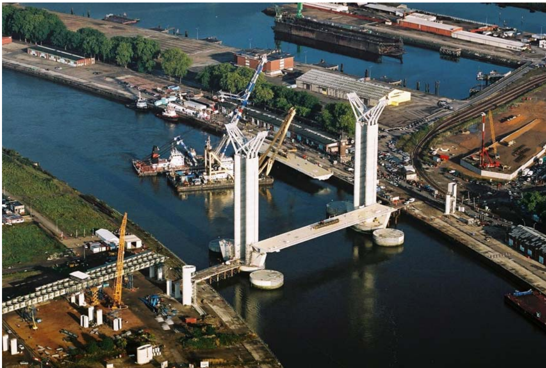
Photo 17 : Vue générale après pose de la 1 ère travée
