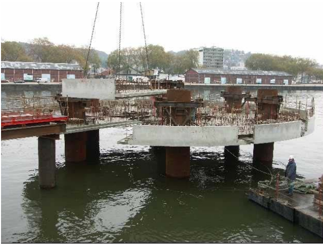
Photo 5 : Pose d'un élément préfabriqué de radier de gabion
