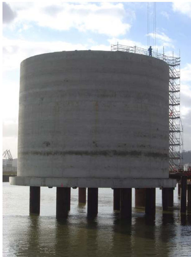
Photo 7 : Gabion terminé reposant sur des gaines métalliques provisoires avant descente en fond de Seine
