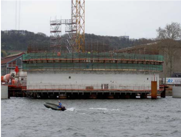
Photo 2 : Coffrage glissant d'un socle
