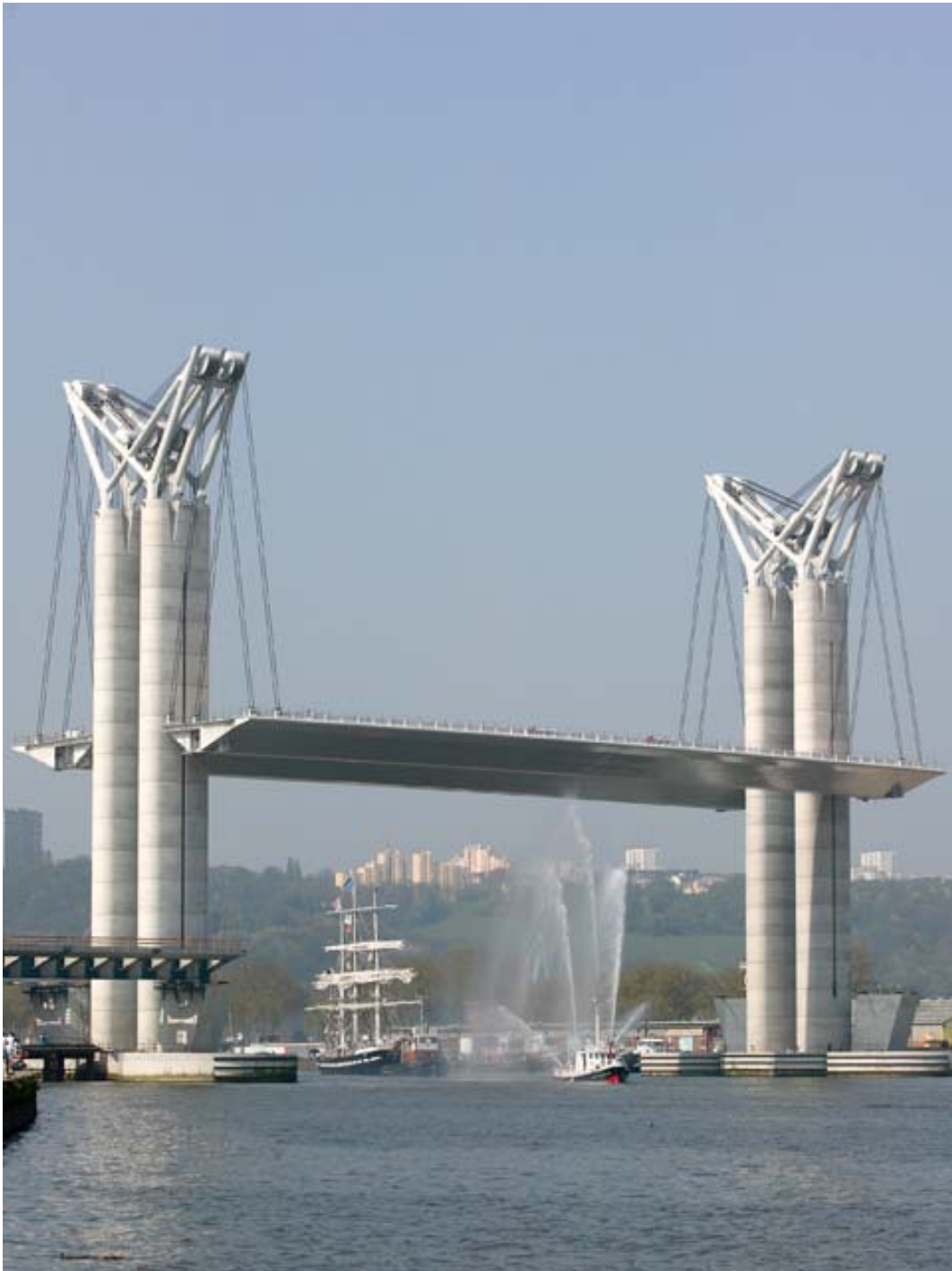
Photo 20 : Passage du Belem sous l'ouvrage le 14 avril 2007
