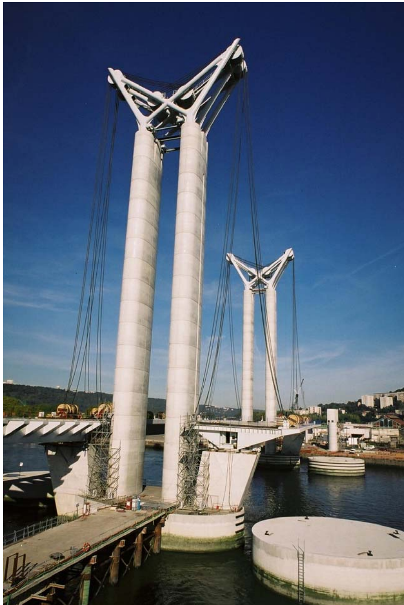
Photo 19 : Installation des câbles de levage
