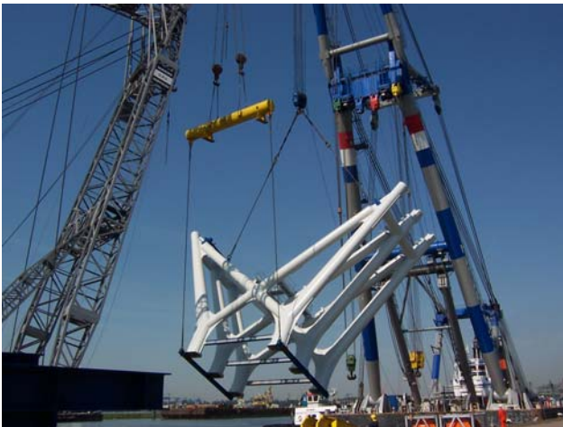
Photo 12 : Relevage d'un papillon à Rotterdam
